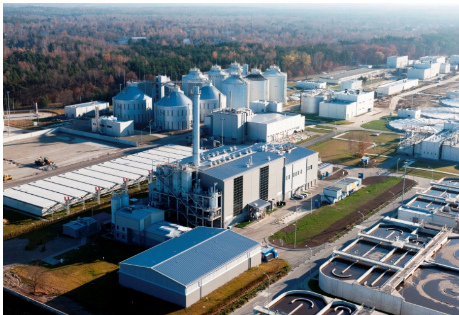
Rys. 12. STUOŚ w Oczyszczalni Ścieków „Czajka” w Warszawie [25]
