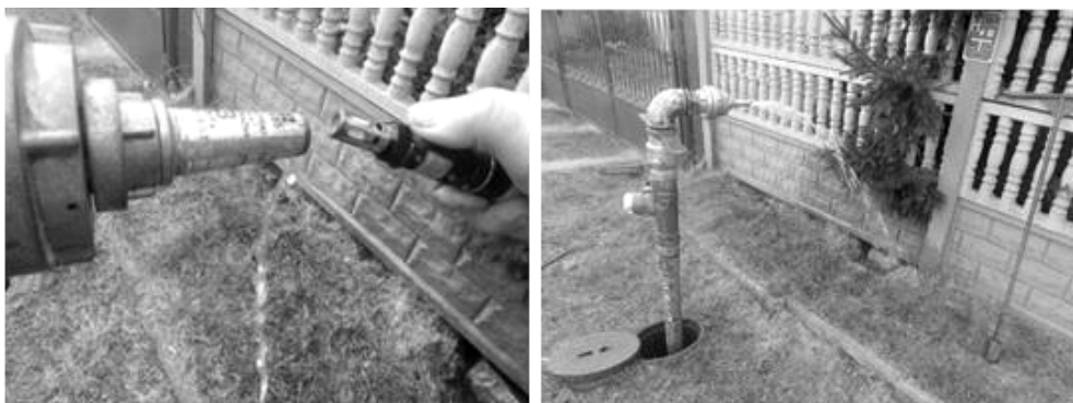
Rys. 1. Przygotowanie hydrantu do poboru próbki pod kątem badań mikrobiologicznych
